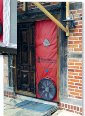
BlowerDoor Messung im Rahmen einer Fachwerksanierung
