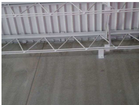
Innensituation: Höhe über Flur 6 m
